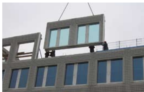
Plaatsen op de bouw
