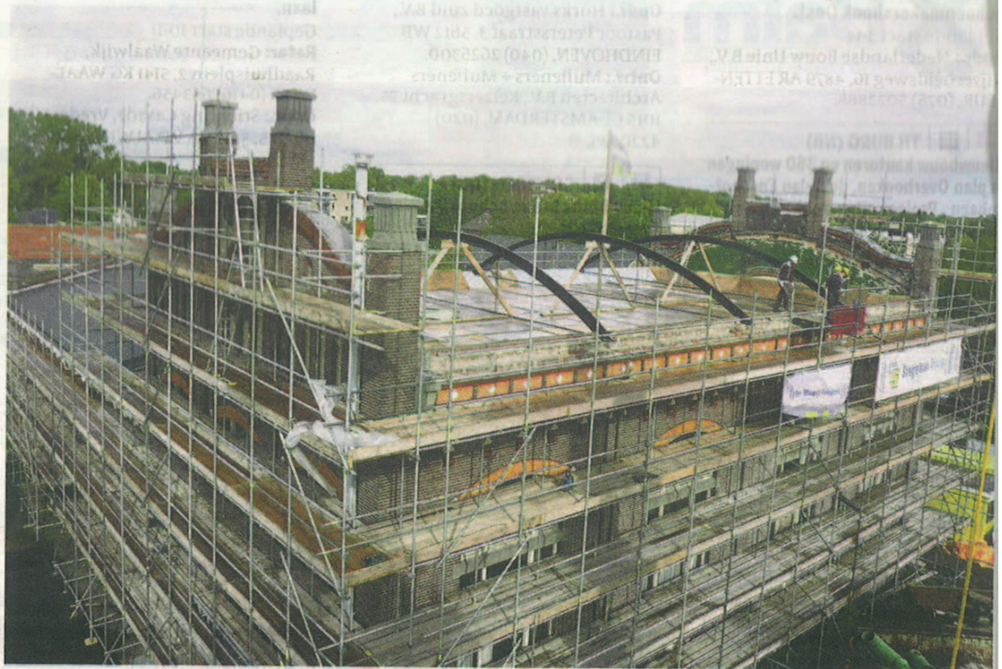
De drie spanten werden afgelopen week naar hun eindbestemming gehesen. De schil van de getoogde draagconstructie is in de nieuwe uitvoering 8 centimeter dik. Foto: Toma Tudor
